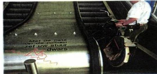
Escalera mecánica diseñada para su utilización por ciclistas en un intercambiador de transporte holandés.
