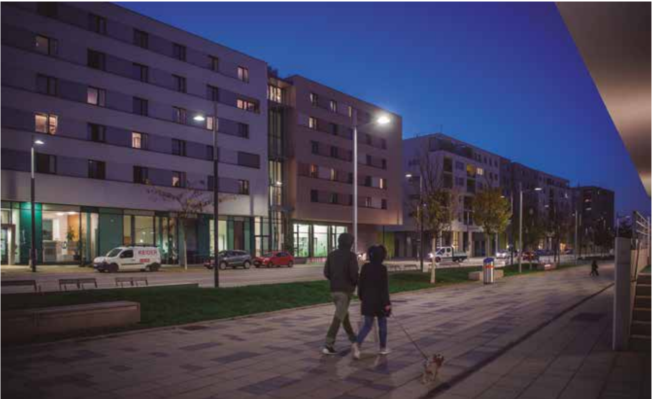
Iluminación separada en aceras amplias de Sonnenallee, Aspern. / Luzia Puiu © 3420AG
