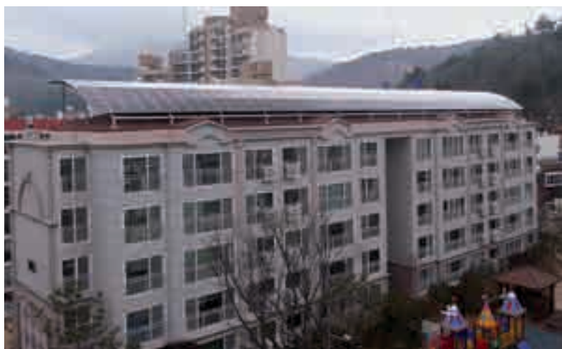
Bâtiment doté de panneaux photovoltaïques
