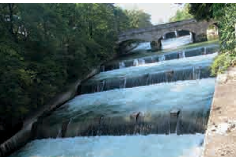
Teulada fotovoltaica. Cotxera del tramvia, Ständlerstraße. Font: SWM. Façana fotovoltaica. Fàbrica Pasing. Font: SWM. Planta hidràulica Praterkraftwerk. Font: SWM / Green City Energy GmbH.
