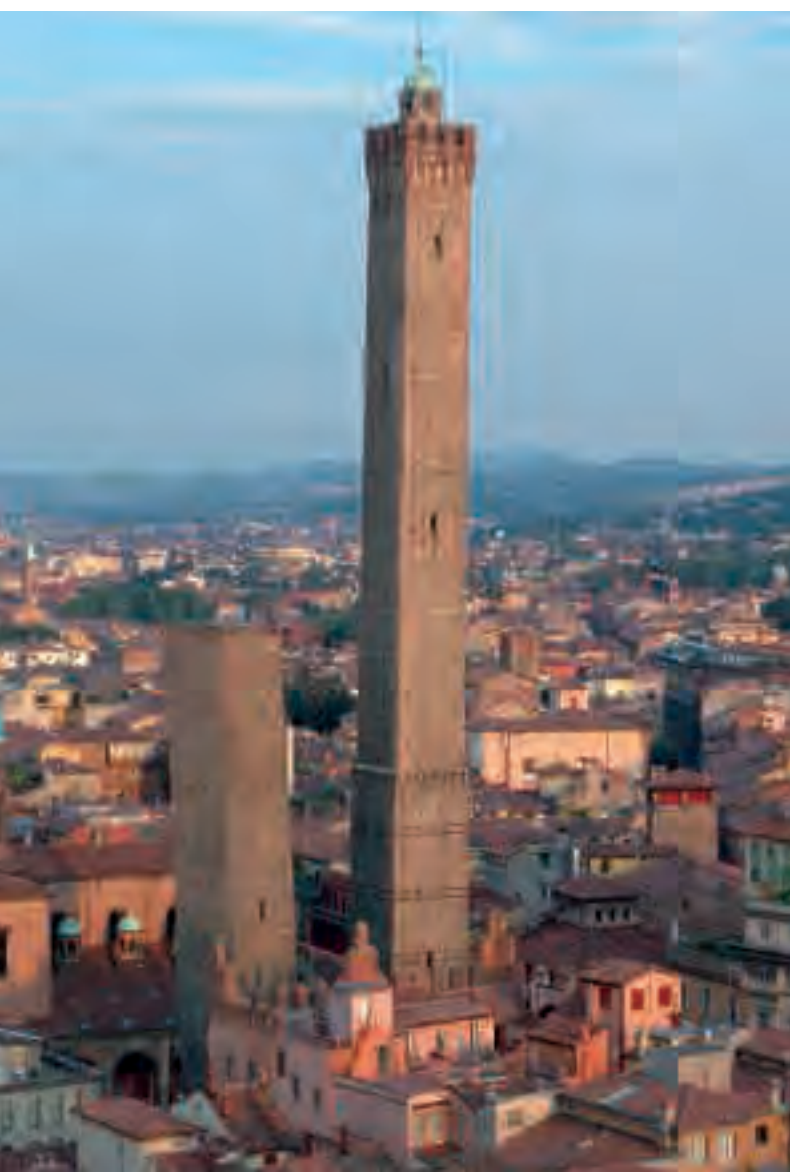
Vista panoràmica de Bolonya
